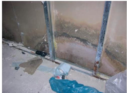
Abb. 4: Leitungswasserschaden
