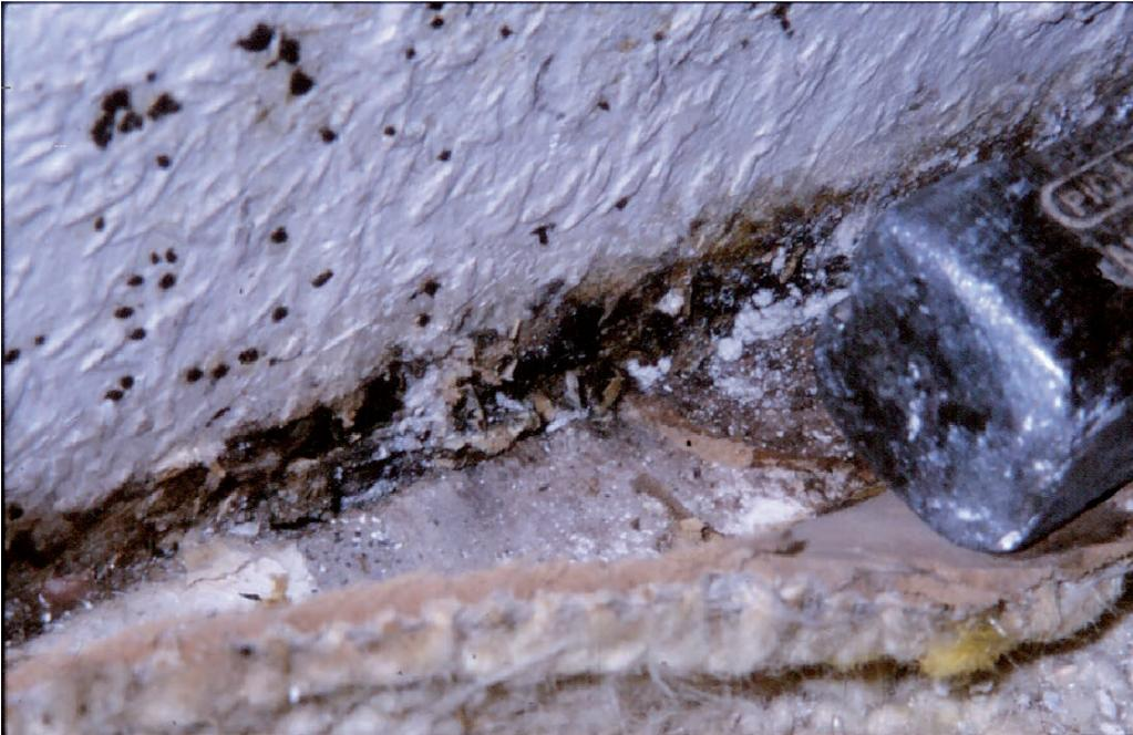
Abb. 6: Mikrobielle Zersetzung von feuchteschädigten Baustoffen in einer Fußbodenrandfuge
