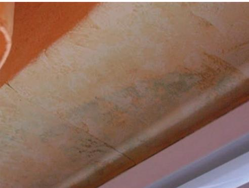
Abb. 3: Geringe Absorption von Feuchtigkeit an Bauteiloberfläche an Wärmebrücke
