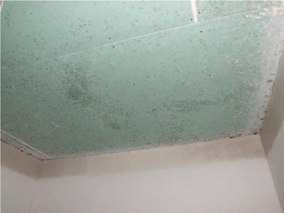
Abb. 3: Beispiel für unterschiedliche Besiedlung von Gipskarton (Decke) und Gipsputz (Wand).
