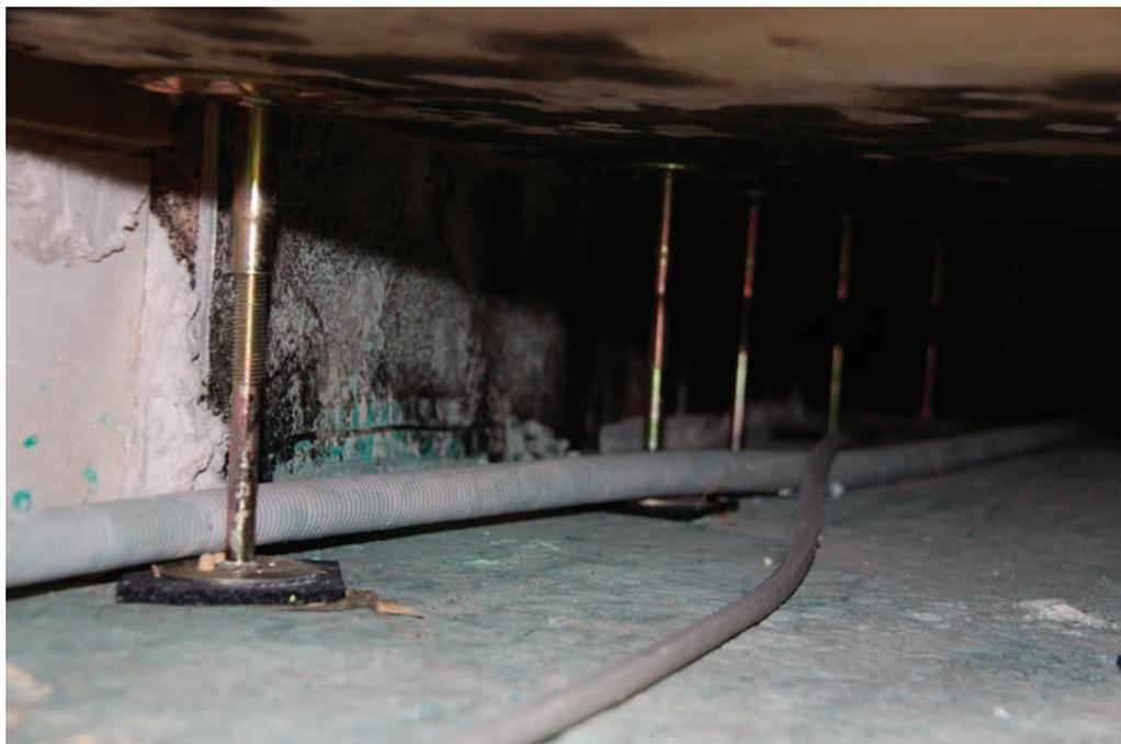
Abb. 4: Beispiel für unterschiedliche Besiedlung von Gipskarton (Wand) und Anhydritestrich (Decke) einerseits sowie Beton (Boden) andererseits.
