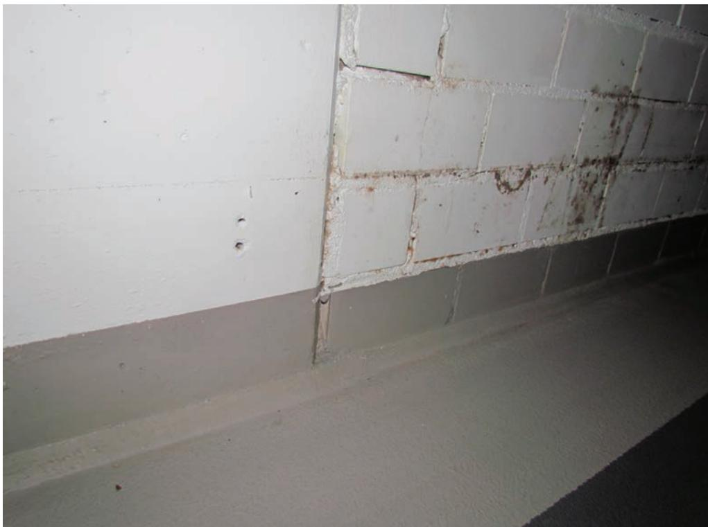
Abb. 2: Beispiel für unterschiedliche Besiedlung Beton (links) und Kalksandstein (rechts) nach einem Hochwasserschaden.
